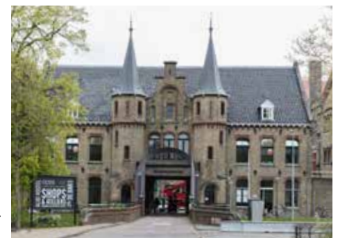
DE BLOKHUISPOORT IN LEEUWARDEN. DE HERBESTEMDE GEVANGENIS IS OP 9 NOVEMBER PLAATS VAN HANDLING VAN HET NATIONAAL MONUMENTENCONGRES 2017 (FOTO JAN VAN DALEN).
